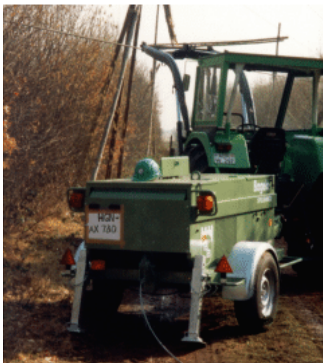
Dźwignik śrubowy KW3F przy zdejmowaniu liny napowietrznej 110kV
