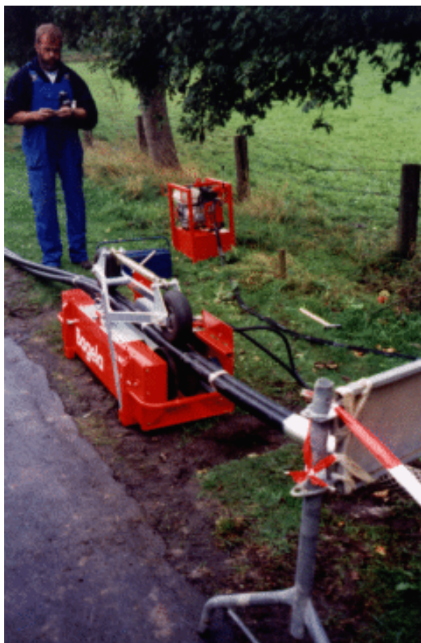
Układanie wiązki 3 jednożyłowych kabli energetycznych 30kV
